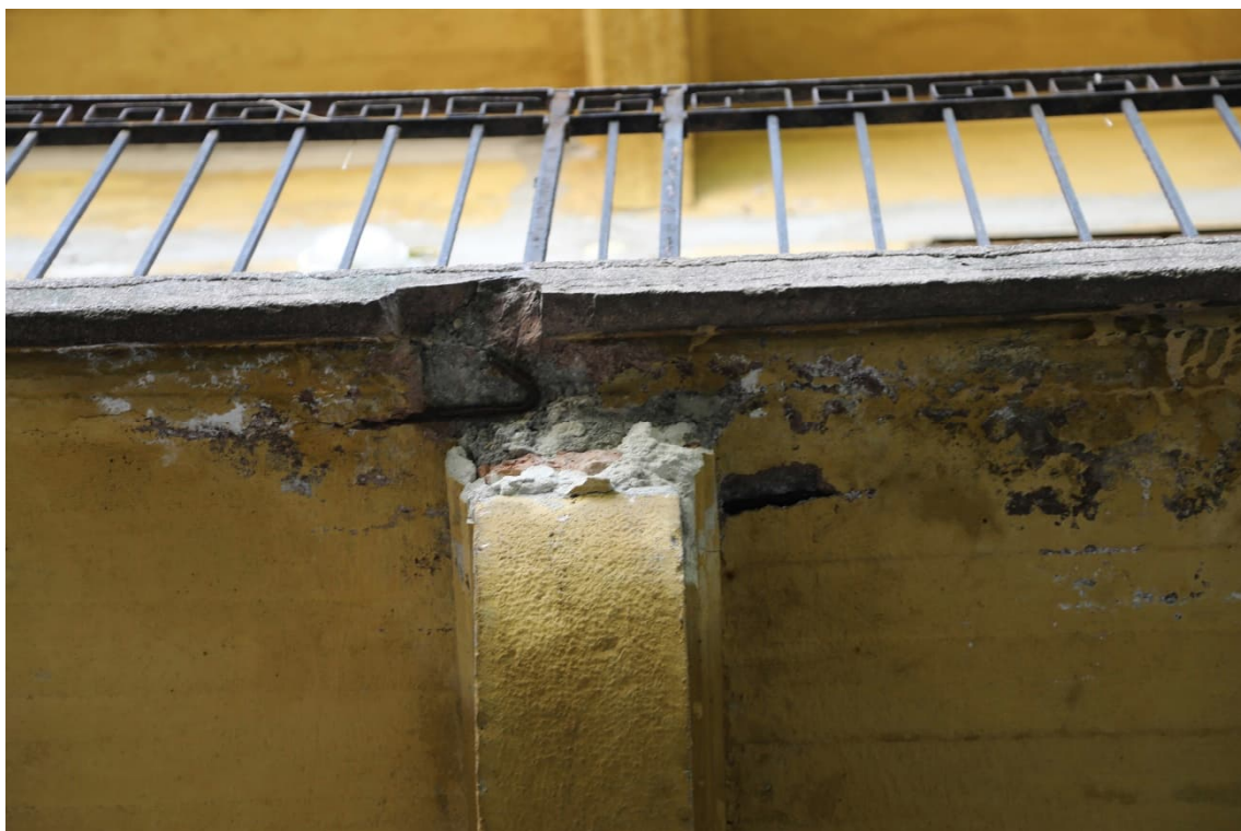
Kezdődő betontakarás leválás.
