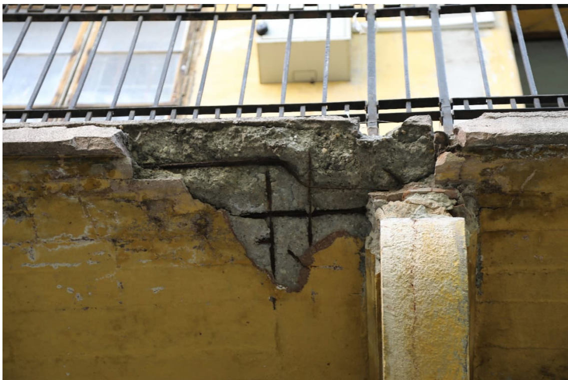
Szintén betontakarás lefagyás látható.
