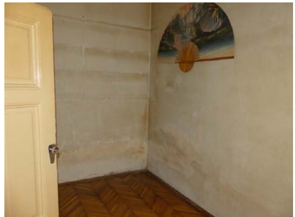
8. kép: Felületi elszíneződés az egyik földszinti lakás falán
