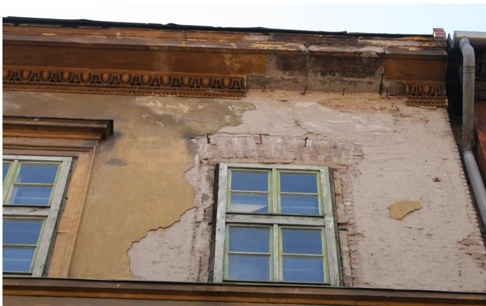
főpárkány, osztópárkány, hiányzó II. emeleti ablakkeret és szemöldök
