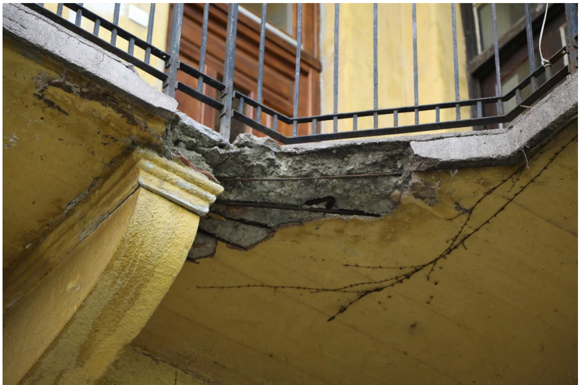
Jelentős betonleválás tapasztalható. Sima betonacélokat tettek a vasbeton lemezbe.
