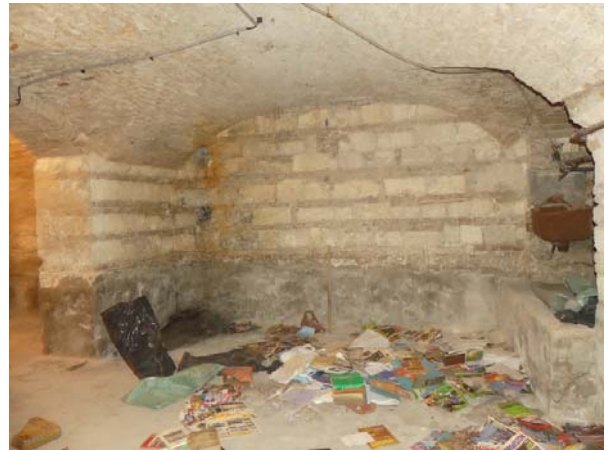
6. kép: Pincszinti falak, a lábazati részen cementes vakolattal
