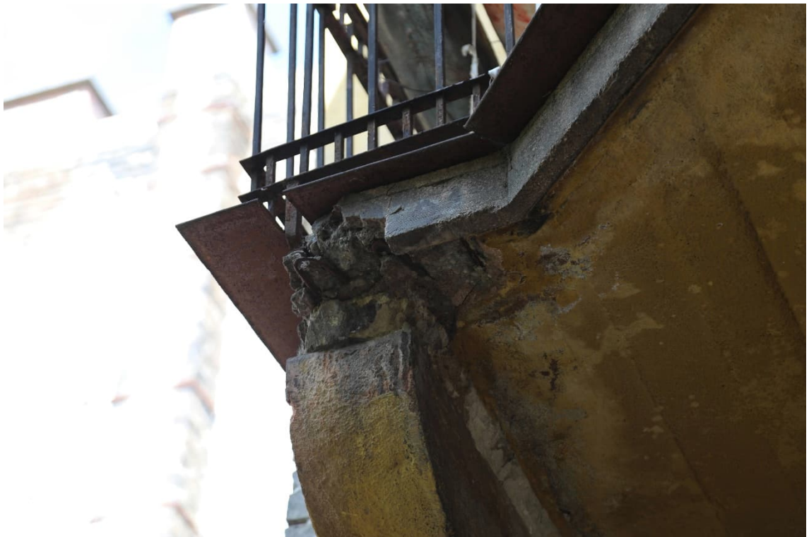
A betonacélok korrodáltak a beton lefagyott.
